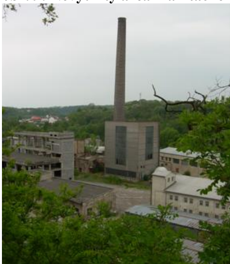
Obr. 9: Nevyužitý areál na Ptácké ulici
