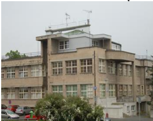
Obr. 21: Stavba od Jiřího Krohy
