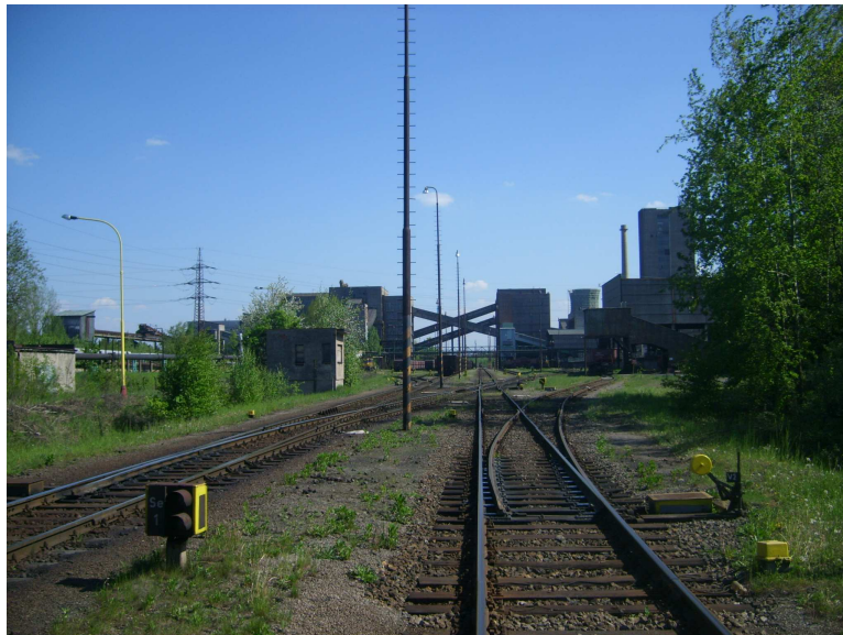
Obr. 7 Objekt Dolu ČSM – sever (I. Siudová, 5. 4. 2009)
