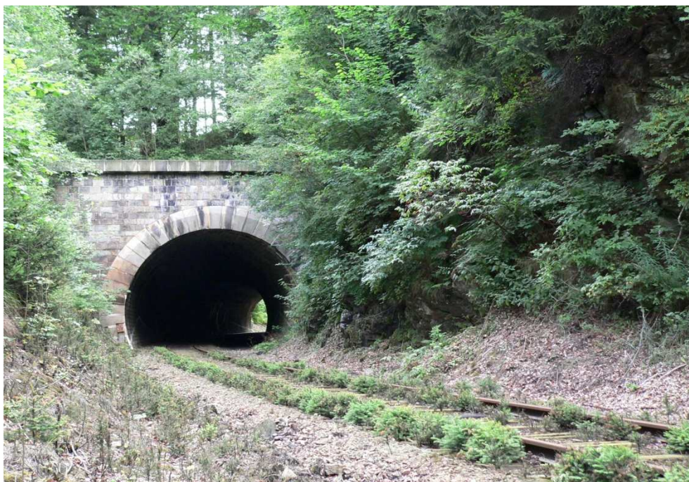
Obr. 9: Železniční tunel u Vlaského (foto: Koubová, V., 14. 8. 2008)
