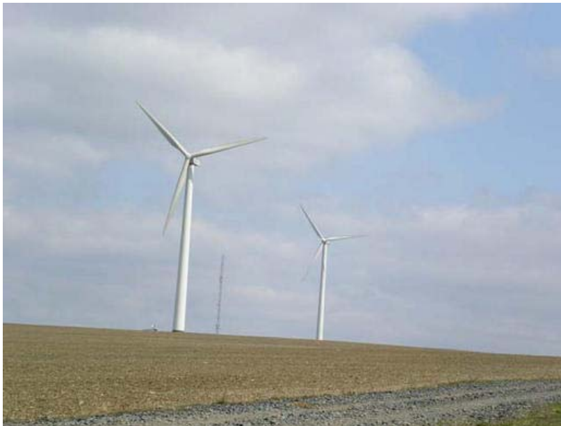
Obr. 10. Větrná elektrárna na území obce Hraničné Petrovice
