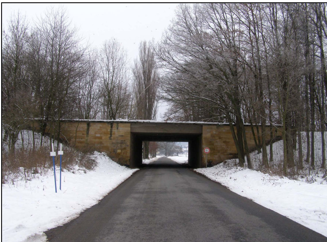
Obr. 9: Most přes silnici III/3844 (Vanovice – Šebetov) (foto z 17. 11. 2007)
