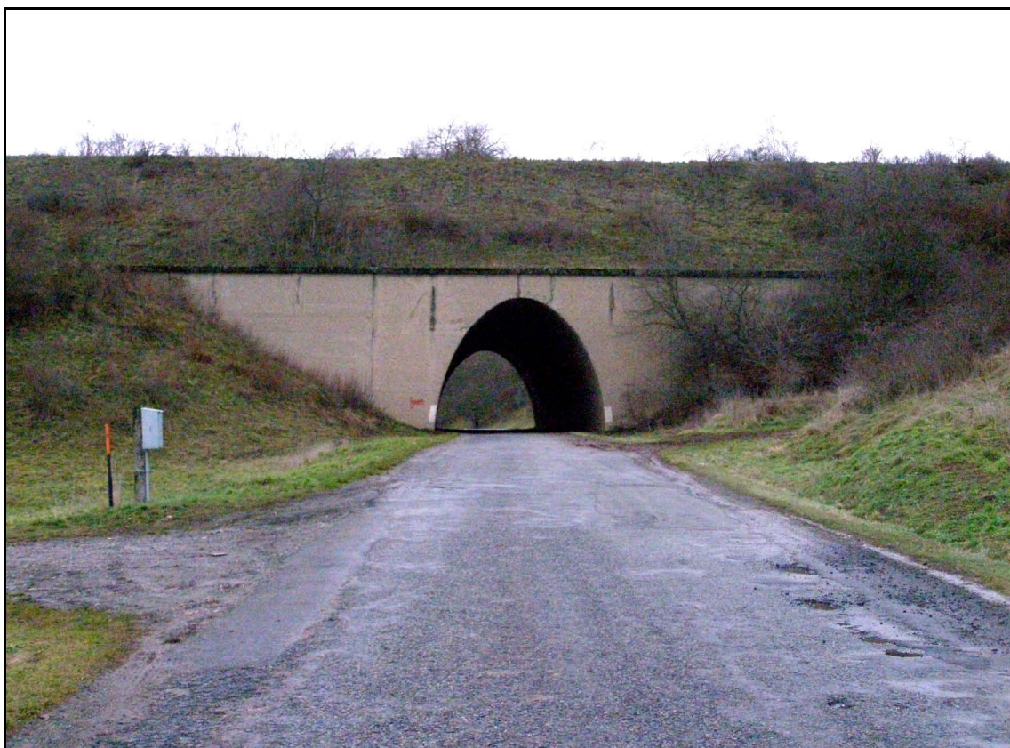
Obr. 12: Most přes silnici III/37415 (Sudice – Bačov) a jeden z nejvyšších násypů u nás (foto z 25. 11. 2007)
