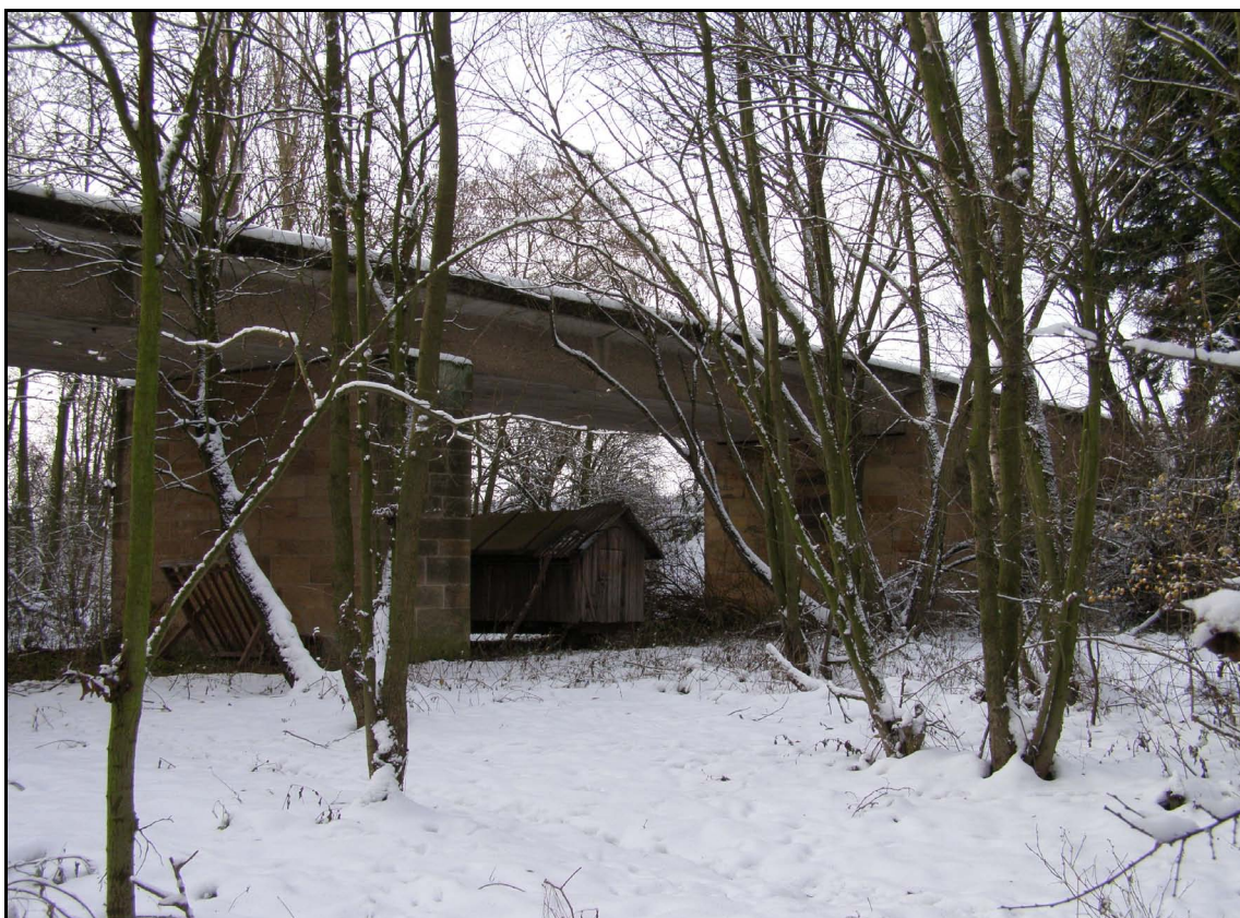
Obr. 8: Most na přeložce polní cesty (Vanovice – Světlá) přes německou dálnici (foto z 15. 11. 2007)
