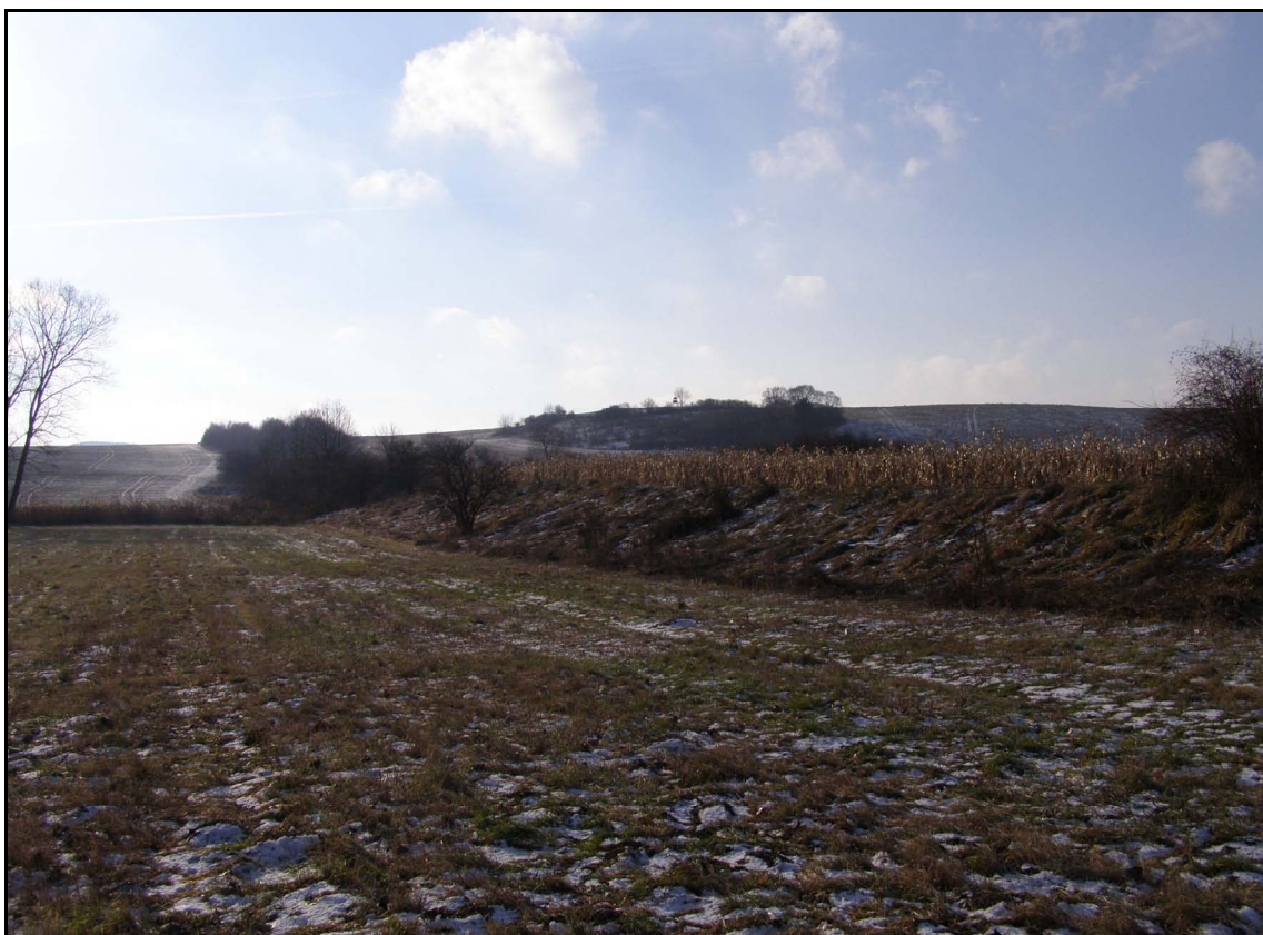
Obr.16: Část tělesa (násep) nedokončené německé dálnice v blízkosti Černé Hory (foto z 29. 11. 2007)
