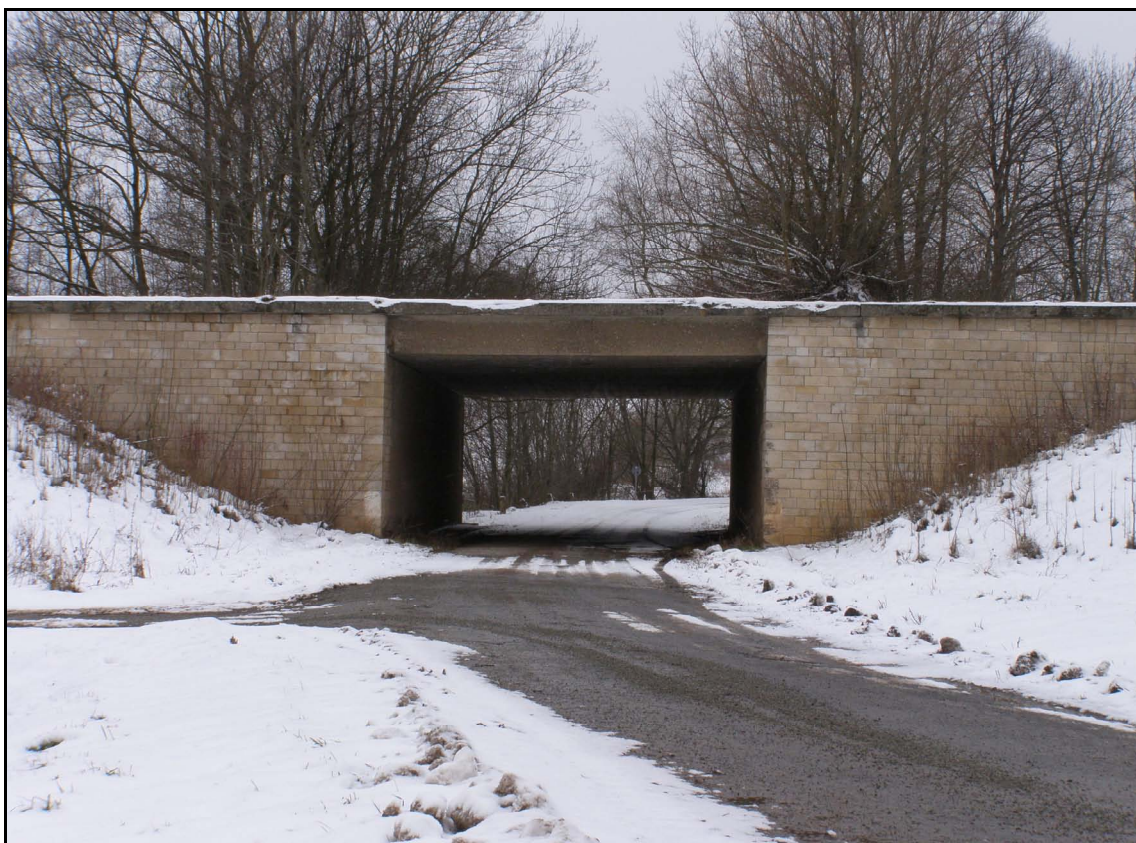
Obr. 11: Most přes silnici III/37414 (Sudice – Paměťice) (foto z 16. 11. 2007)
