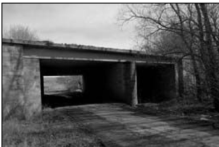
Obr. 6: Deskový dálniční most přes polní cestu (Uhřice – Velké Opatovice)
