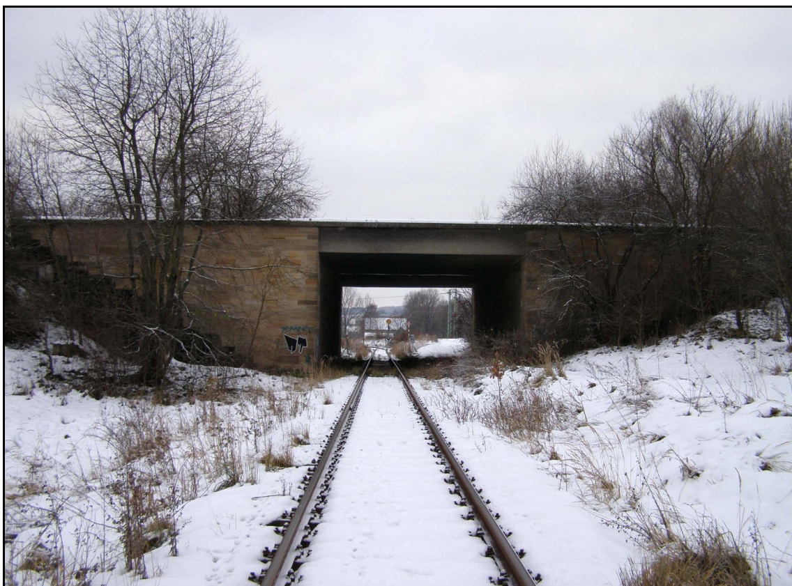
Obr. 6: Most přes železniční trať č. 2021 (Velké Opatovice – Chornice) (foto z 15. 11. 2007)
