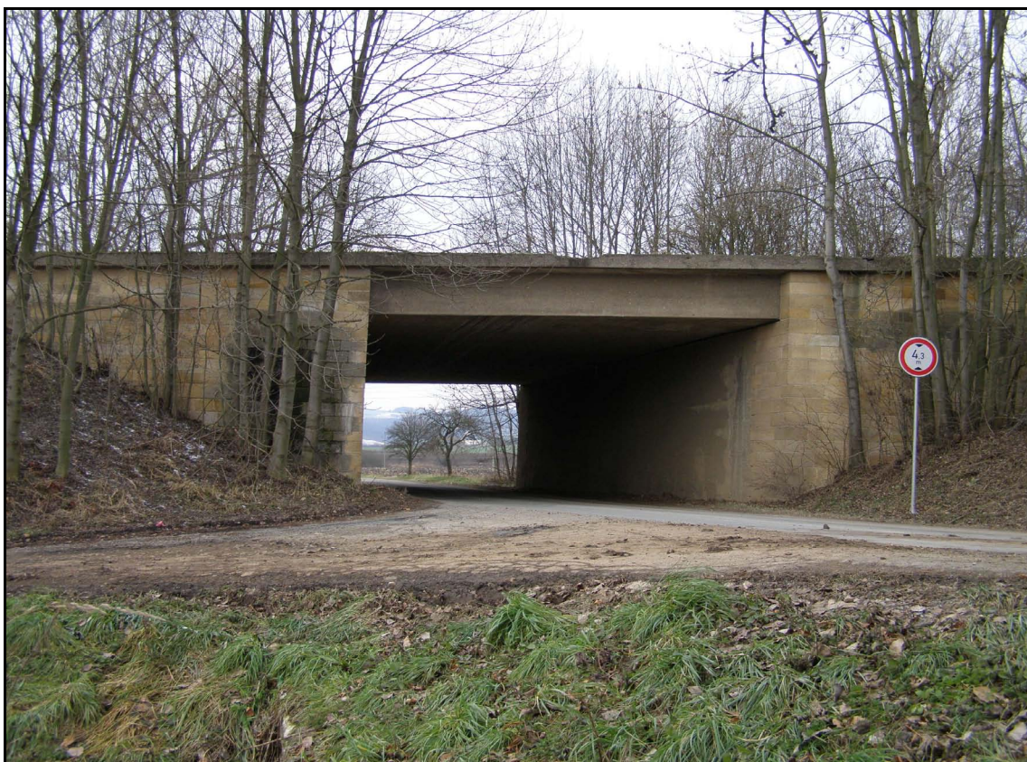
Obr. 13: Most přes silnici III/3764 (silnice I/43 – Drnovice) (foto z 29. 11. 2007)
