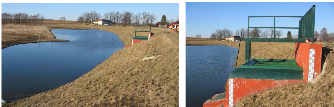
Obrázek 10: Suchá nádrž I. v katastrálním území Moravský Lačnov. Hladina normálního nadržení suché nádrže. Obrázek 11: Sdružený objekt s vodočetnými latěmi.
