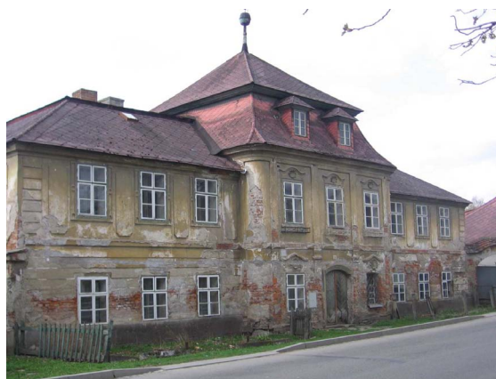
Obr. 6 Budova bývalé Klapperothovy manufaktury
