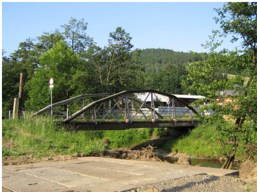
Obr. 29 Silniční most v Hrabenově
