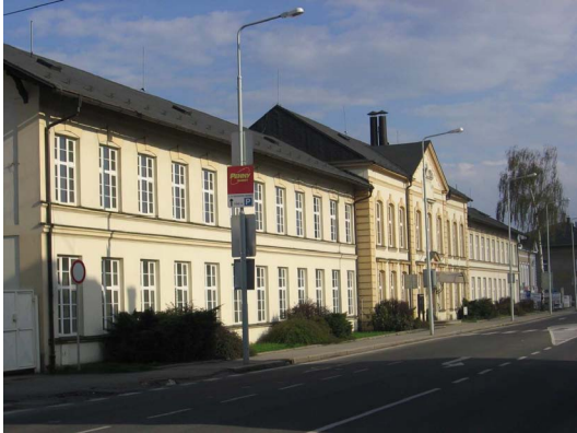
Obr. 33 Bývalá Reitererova hedvábnická továrna v Šumperku
