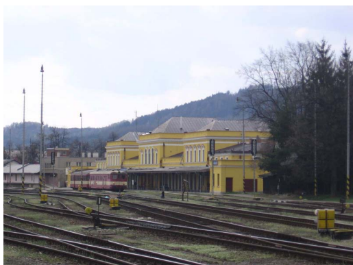
Obr. 13 Výpravní budova šumperského nádraží
