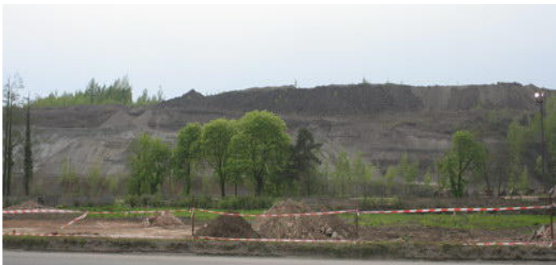
Obr. 14 Pohled na haldu z Frýdecké ulice na východní straně (foto www.hctrinec.cz , 24.3.2008)
