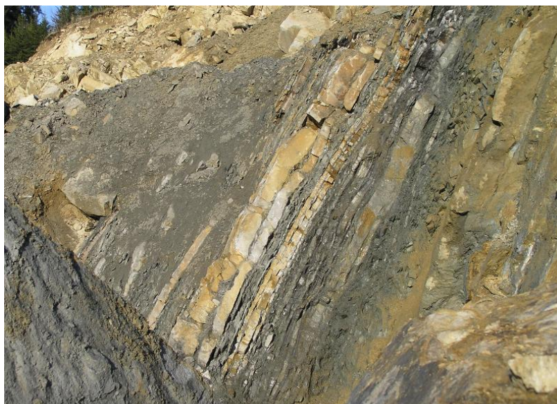
Obr. 3 Magurský flyš – lom v údolí Štěpková. Žlutošedě navětralé, středně až hrubě zrnité arkózové pískovce proložené šedými jílovcí (Š. Křupalová, 30. 3. 2008).
