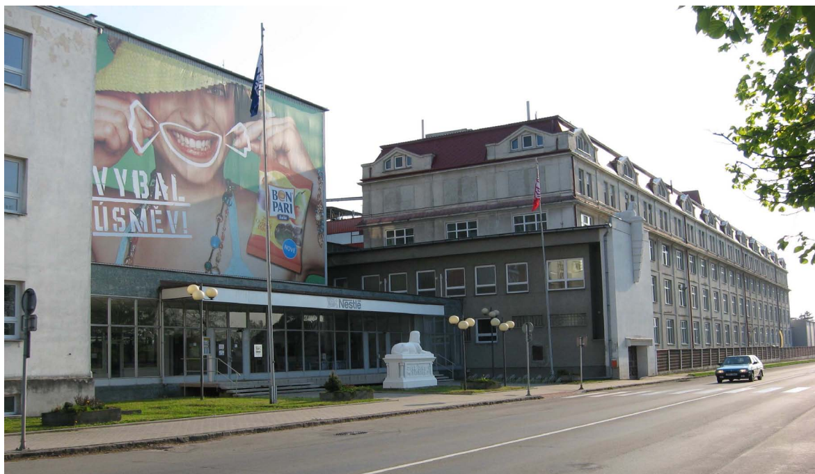
Obr. 1. Hlavní budova – Nestlé Česko s r.o., pobočka Sfinx
