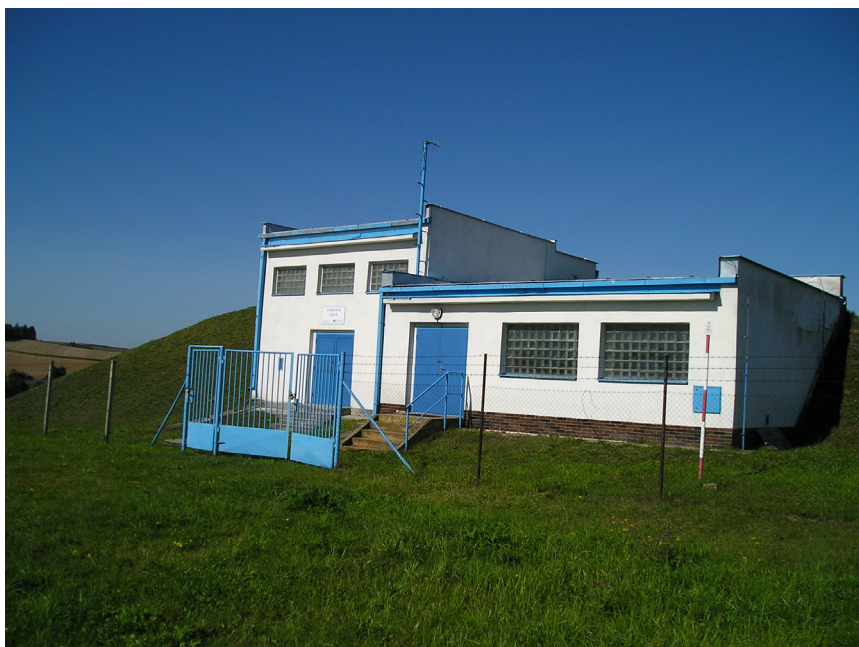
Obr. 3: Vodojem Vídeň (foto: I. Večeřová, 3.8.2006)
