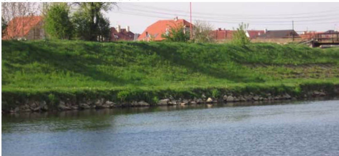
Obr. 15 Ukázka kamenného záhozu 15
