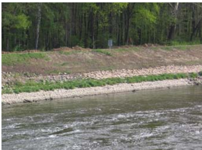
Obr. 16 Ukázka kamenné a betonové dlažby 16
