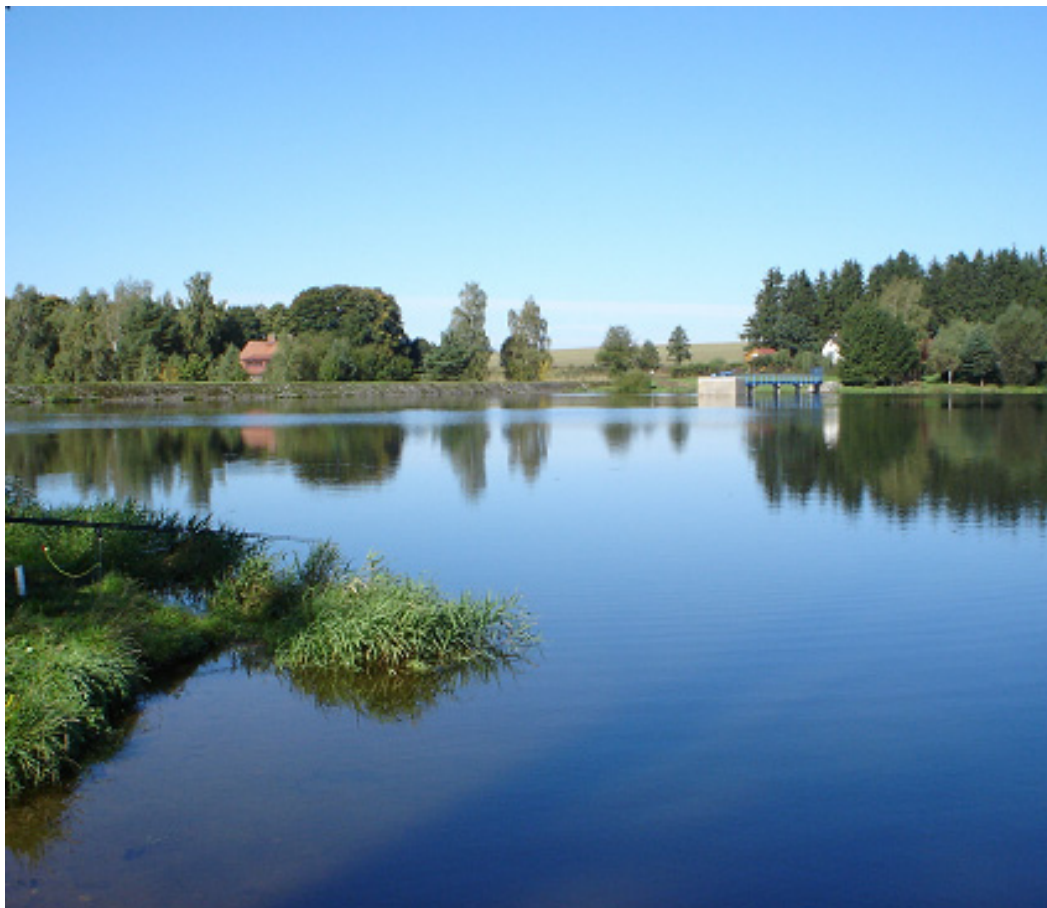
Obr. 4.7: Hráz Břevnické nádrže (Foto M. Šotolová, 2. 10. 2005)
