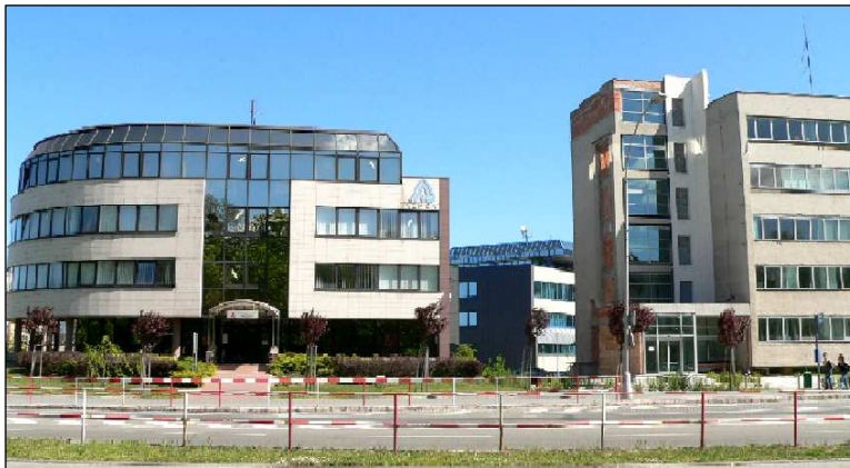
Obr. 45: Dnešní Bělidla – na tomtéž místě rozšířena silnice s budovou Stavebního podniku, VZP ČR a budovou Florie
