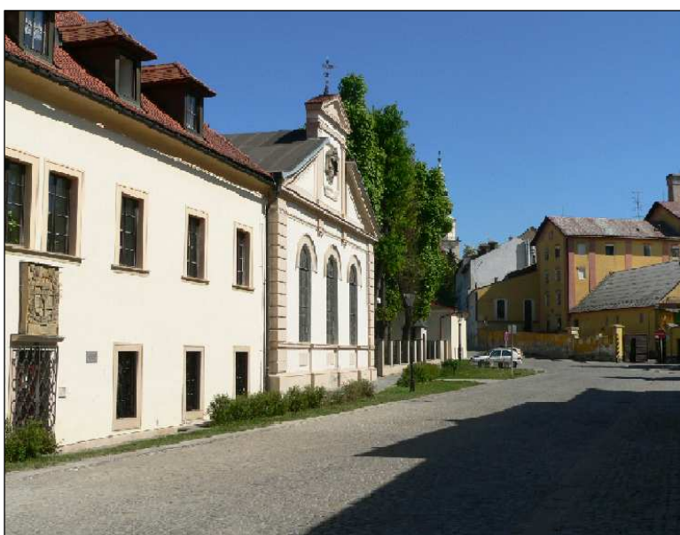
Obr. 26: Na Sladovnách v současnosti – vlevo mincovna, vpravo sodovkárna.
