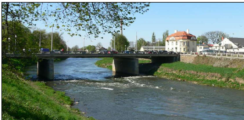
Obr. 15: Dnešní betonový most, který nahradil železný
