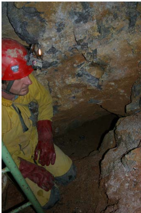
Obr. 7.: Ražba a kopání šachty
