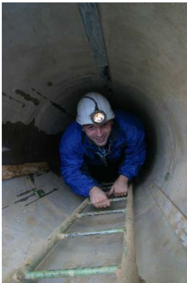
Obr. 8.: Šachta po vyskružení a nainstalování žebříků (Foto E. Příbylová)
