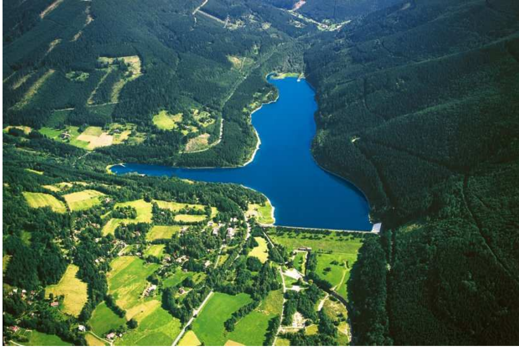
Obr. 9 Vodní dílo Morávka na leteckém snímku (Povodí Odry, státní podnik, http://www.pod.cz )
