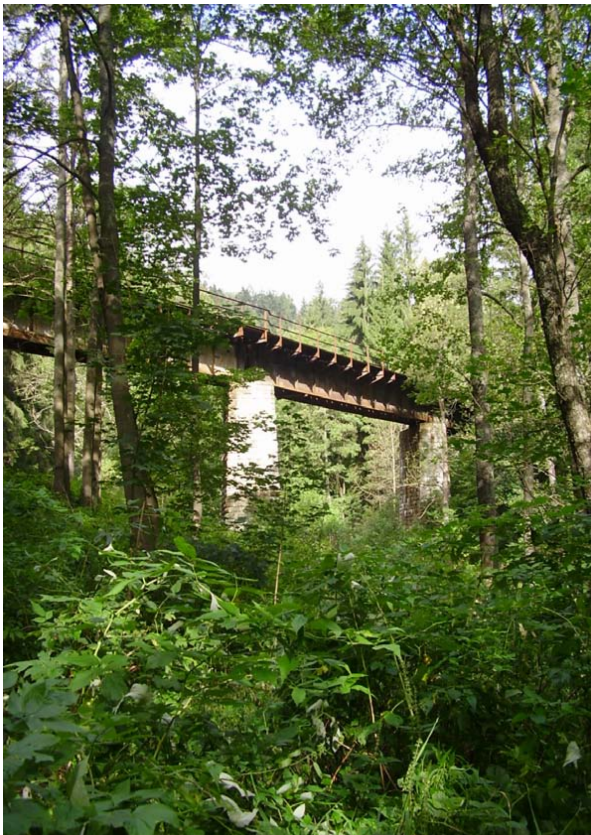
Obr. 4.8 Železniční viadukt přes údolí řeky Krupé (V. Kočí 12. 9. 2006).
