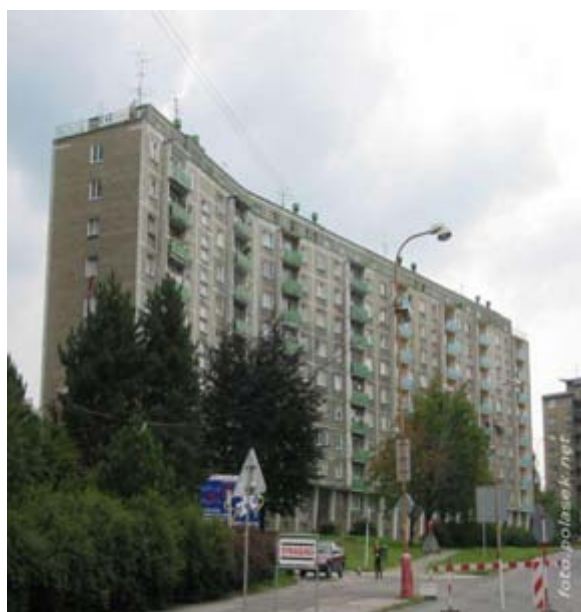
Obr. č. Komplex panelových domu „Hokejka“ v r.2006 (www.polasek.net)
