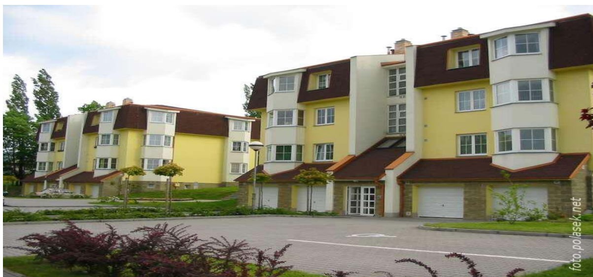
Obr. č.21: Bytové domy na ul. Sluneční ( www.polasek.net )
