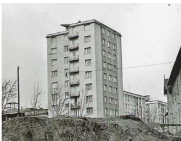
Obr. č. 17: vysoko-podlažní dům v Kopřivnici v r. 1964
