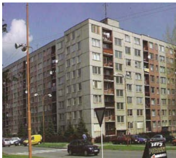
Obr. č.20: Stavba panelových domů na místě „Staré kolonie“ v r.2005
