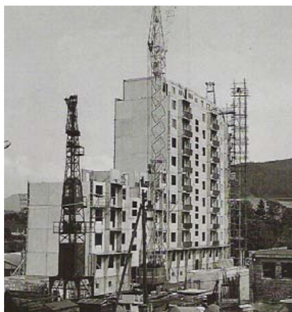
Obr. č. Komplex panelových domu „Hokejka“ při výstavbě v r.1967
