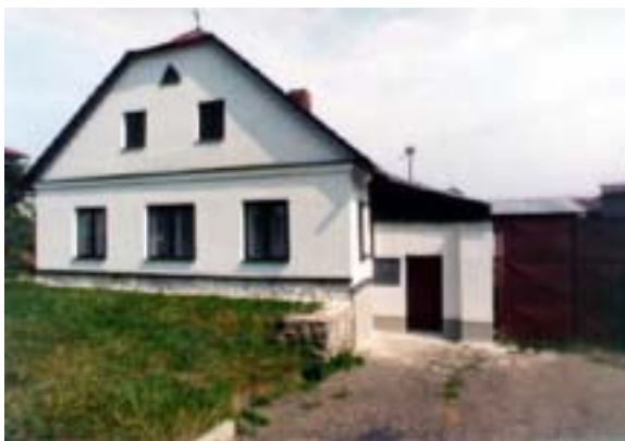
Obr. 5. 3. 3 Rodinný dům ve Stržanově (venkovská výstavba)
