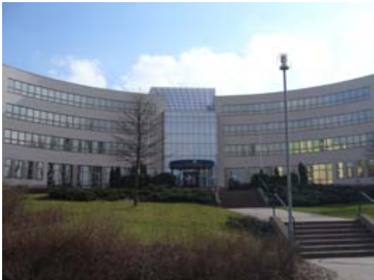
15. Budova státního zastupitelství na strojírenské ulici (90. léta)
