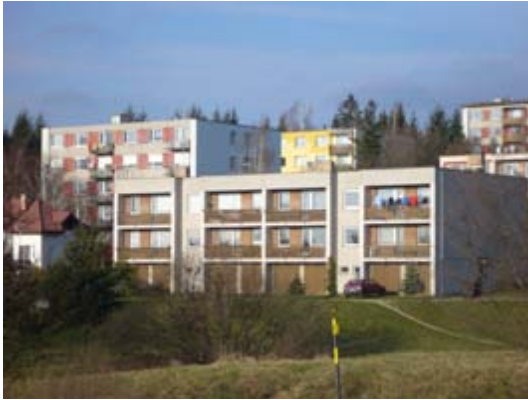
21. Řadová výstavba s garážemi a panelová výstavba na Vodojemu (80. léta)
