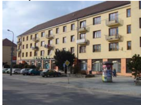
16. Sídliště Stalingrad, zrekonstruované bytové domy (50. léta) v přízemí obchody
