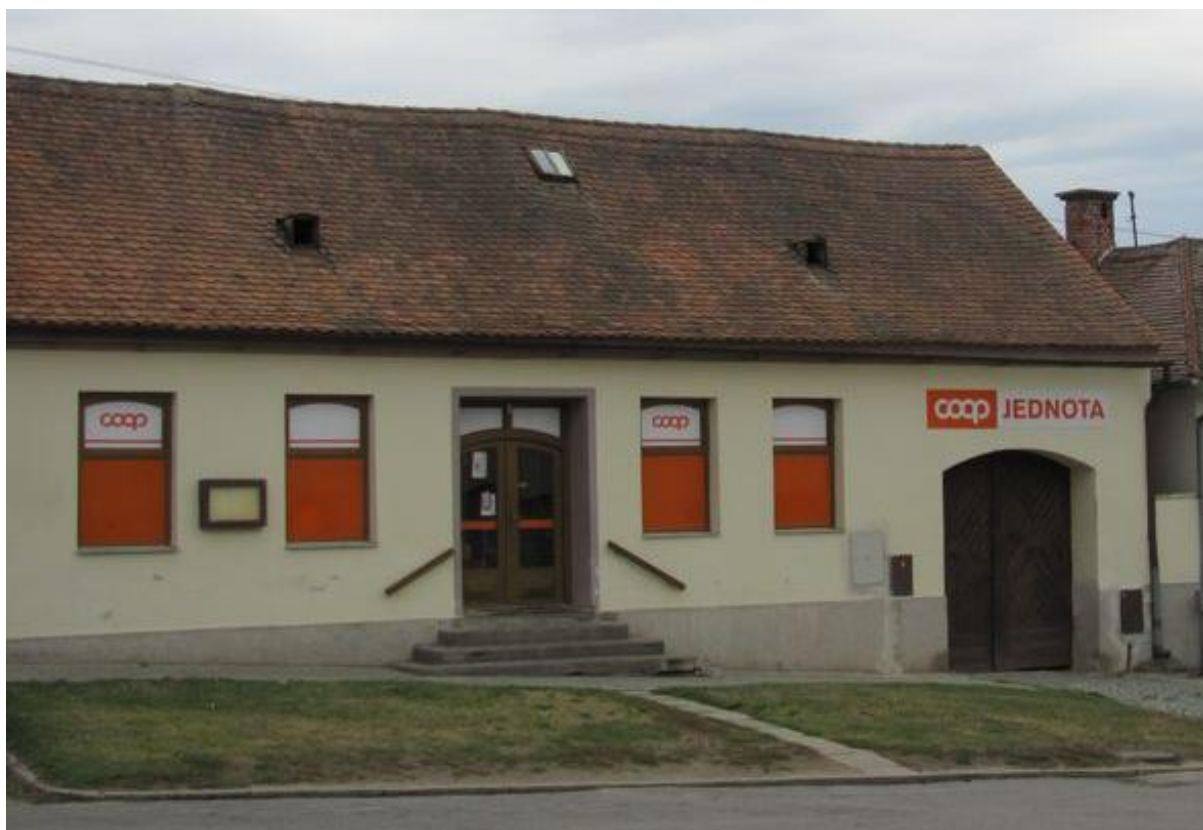
Obr. 6.3: Coop Jednota v Jevišovicích
