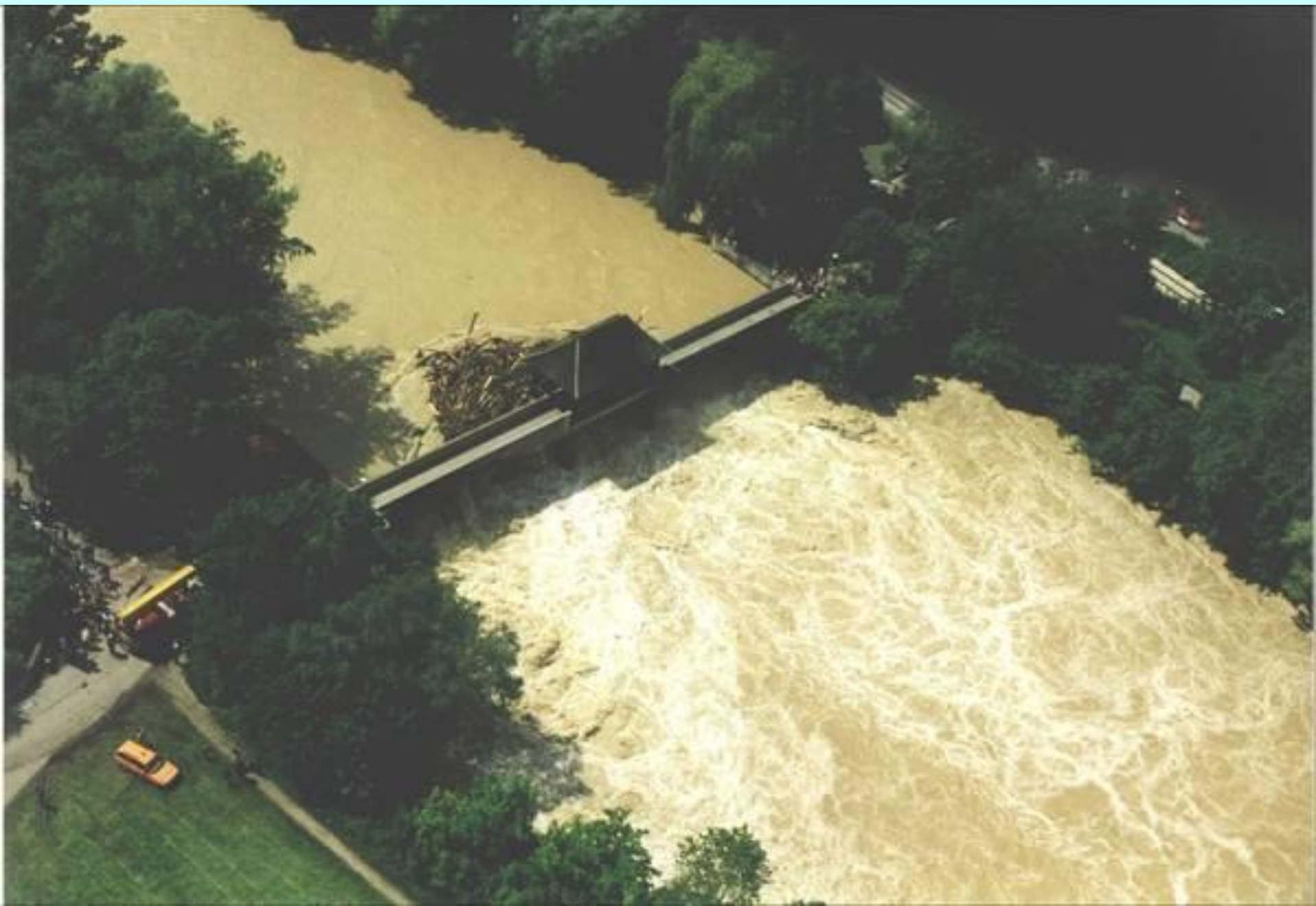
Jez Goggeles při povodni; zdroj internet
